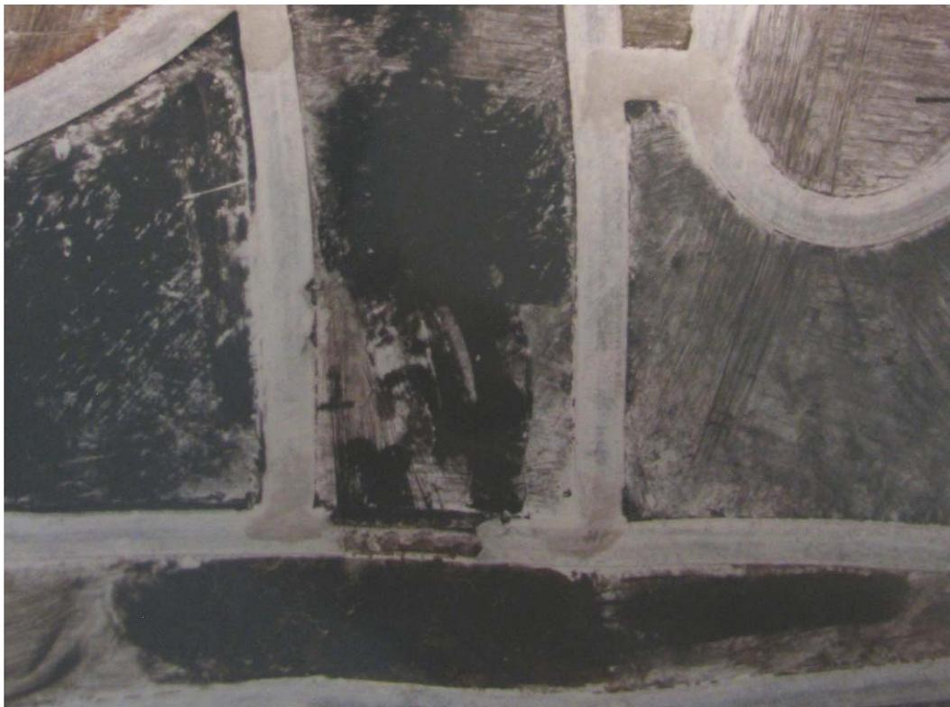
Schadhafte Verbleiung. Gut zu erkennen ist die weisse Patina (Untersuch 1994). Ein Untersuch der EMPA (1994) zeigte, dass für die Verbleiung der Glasgemälde Reinblei verwendet wurde.
