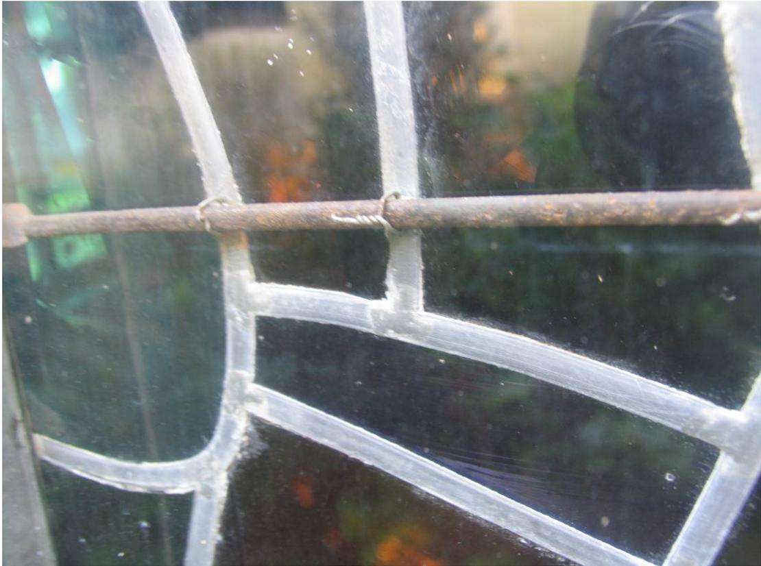
Windstangen auf der Aussenseite (in der Zwischenverglasung). Die Drahthaften sind alle intakt.
