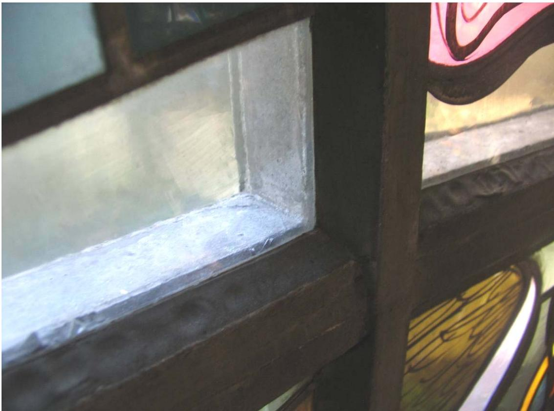
Im Zwischenraum der Scheiben zeigen sich keine Spuren von Schmutzablagerungen oder Kondenswasser.
